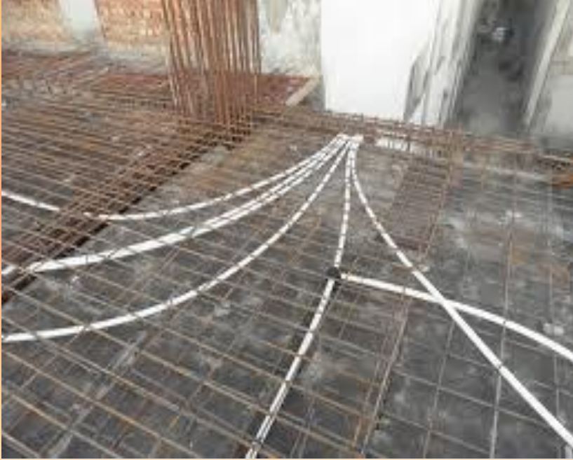
চিত্র: কনসিল্ড কন্ডুইট ওয়্যারিং
